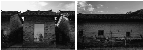
(a)青砖砌墙 (b)两段式砌法
