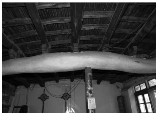
图3 囤顶房屋面构造
