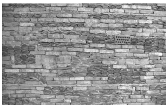
(b)旧砖瓦砌筑的墙体
