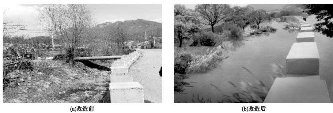
图 18 人工与自然结合护岸改造前后对比
