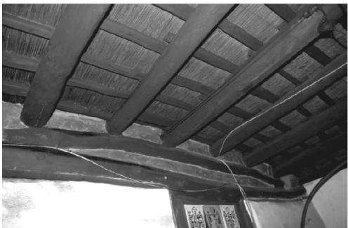
图5 弧形木做法屋顶结构图
